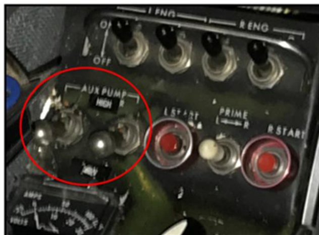
Figura 8. Imagen de los interruptores de bombas auxiliares de combustible
