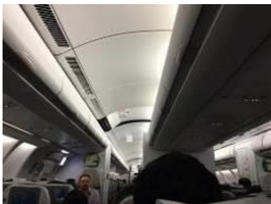
Figura 1. Panel del techo dañado
