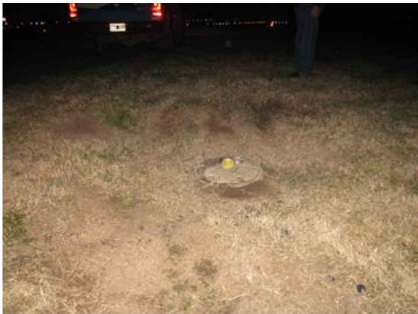
Fig. 2: Baliza rota indicadora extremo de pista 05.
