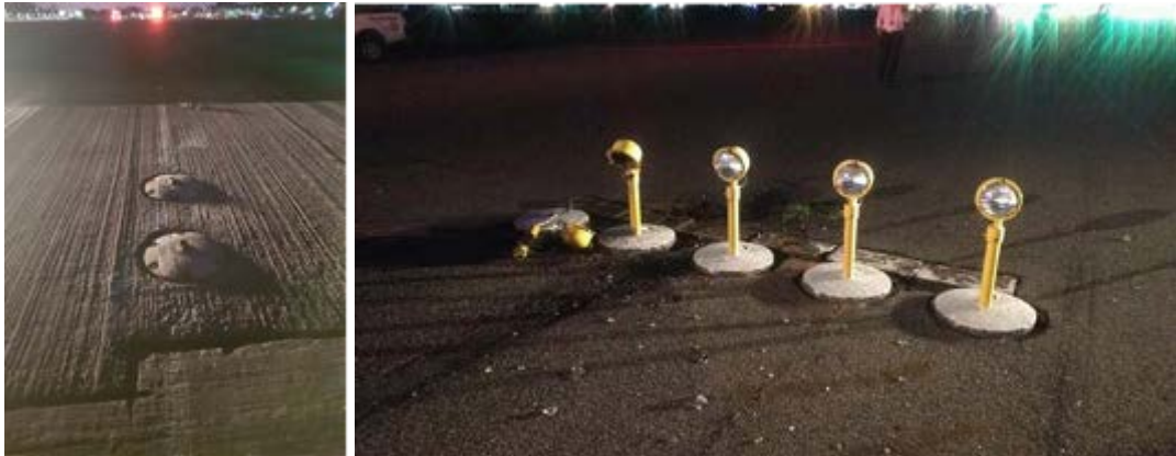
Figura 1. Luces de pista dañadas
