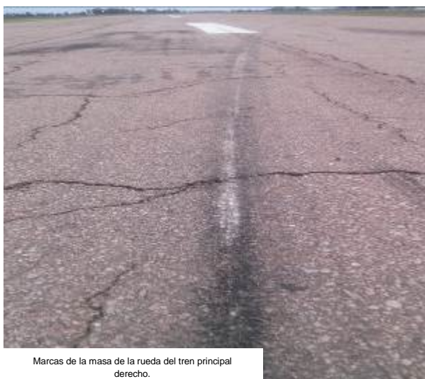
Fig. 3: Imágenes de las marcas dejada en la pista por la aeronave.
