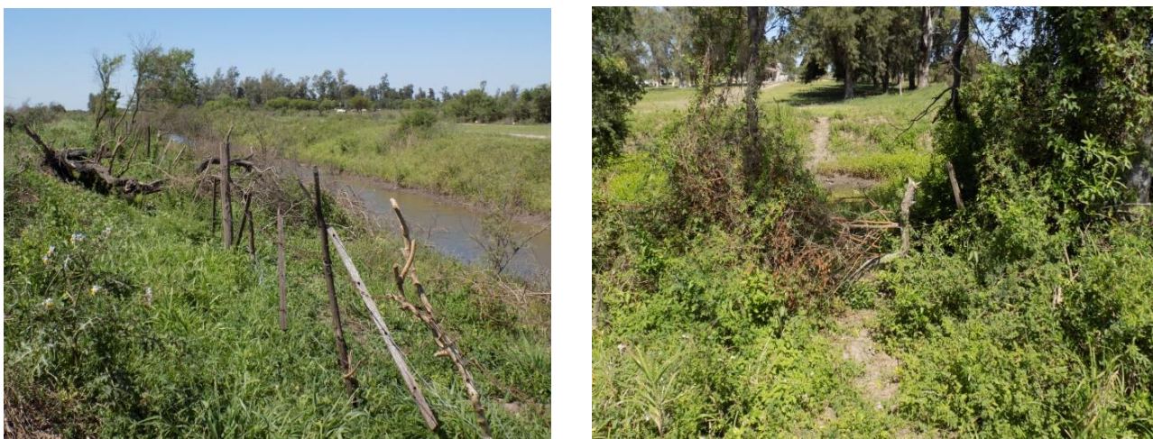
Fig. 5: Vista de la zona de ingreso de equinos al predio y del alambrado perimetral en mal estado.
