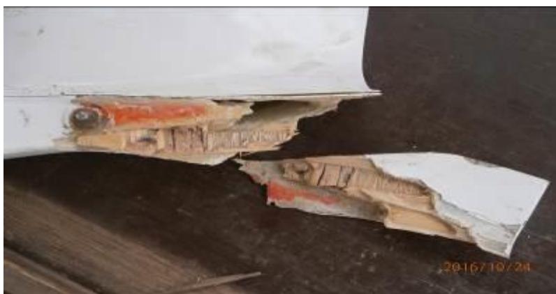
Figura 3. Aleta “winglet”, semiplano derecho deteriorada y arrancada
