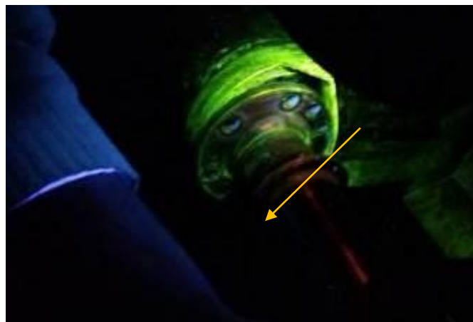
Figura 10. Detección de fisuras a través de ensayos de partículas magnetizables
