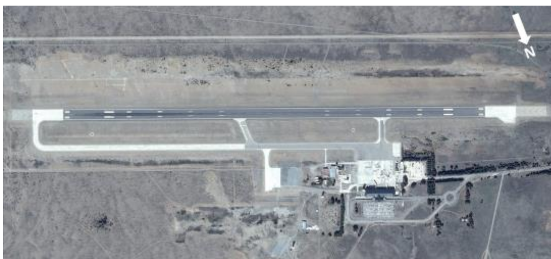
Figura 4. Aeropuerto de San Carlos de Bariloche
