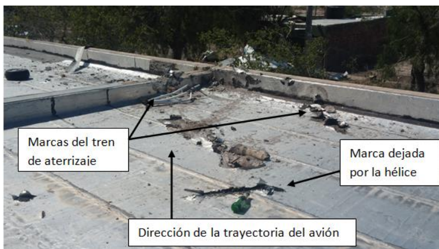
Figura 4. Vista del techo de la escuela
