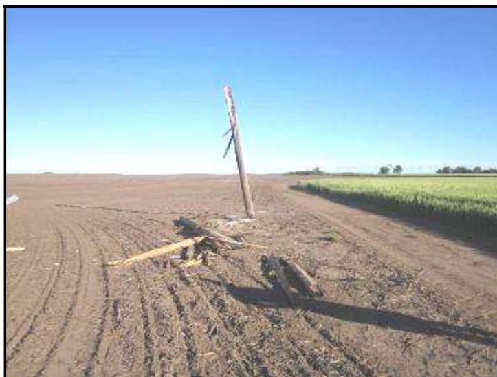
Figura 1. Vista del poste de palmera
