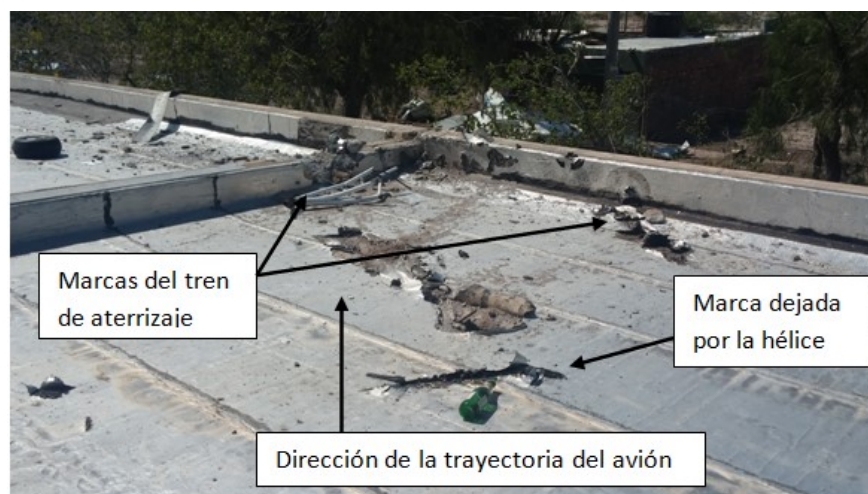
Figura 4. Vista del techo de la escuela
