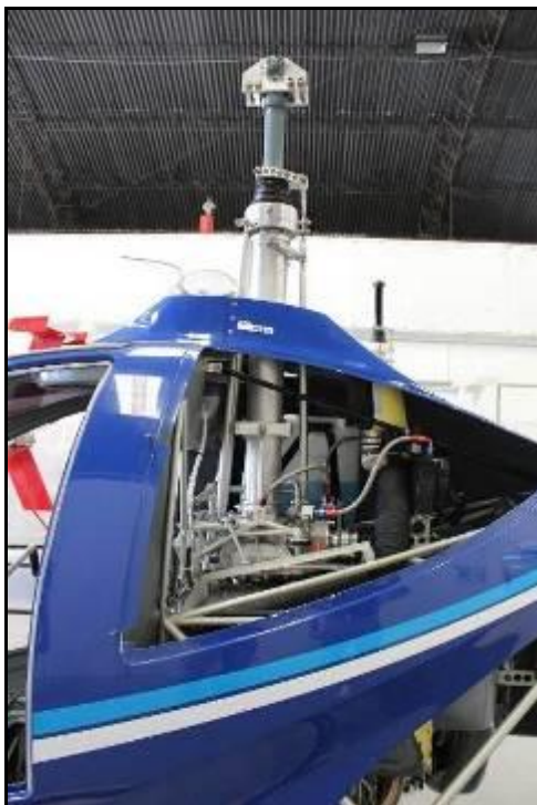
Figura 3. Vista del sistema de varillaje que comanda el paso cíclico y el colectivo, instalado sobre el mástil y caja de transmisión principal ( imagen ilustrativa obtenida de un helicóptero en proceso de fabricación )
