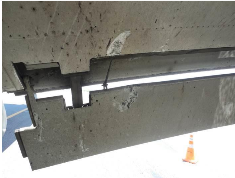
Figura 3. Daños en el ala izquierda
