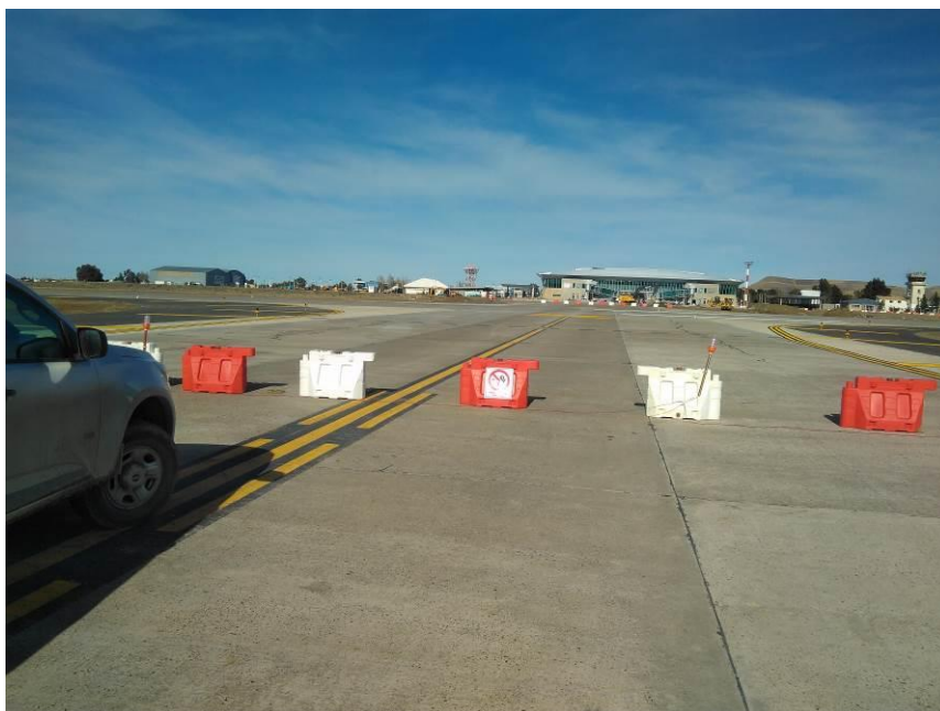
Figura 2. Imagen de vallas limitadoras de acceso a pista.
