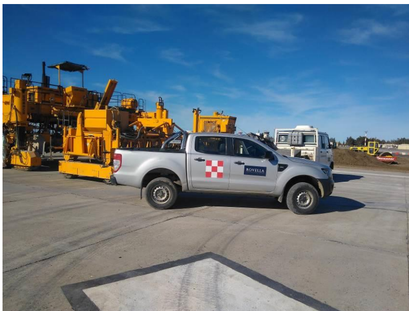
Figura 3. Imagen del vehículo y máquinas de obra.
