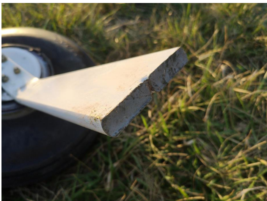
Figura 3. Zona de rotura de la ballesta del tren de aterrizaje principal derecho
