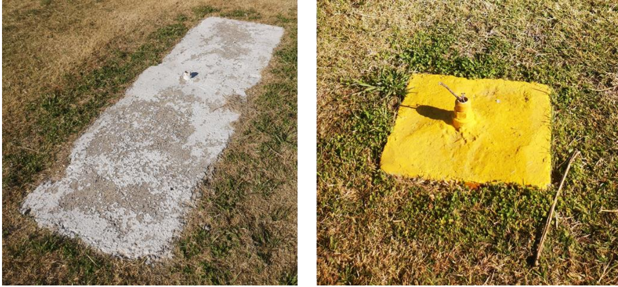
Figura 6. Ejemplo de balizas rotas en el aeródromo de Mercedes
