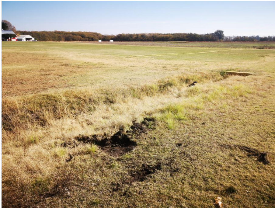
Figura 3. Zanja presente en el aeródromo de Mercedes
