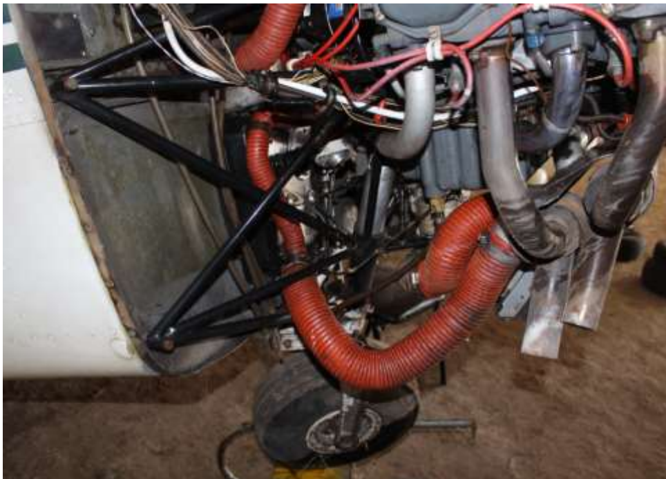
Figura 6. Daños en el amortiguador de tren de nariz
