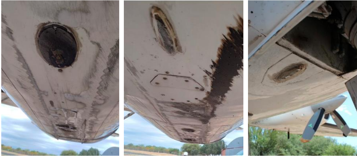
Figura 3. Antenas de la parte inferior del fuselaje destruidas
