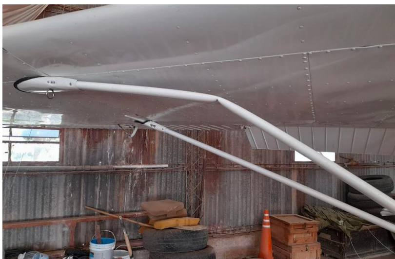
Figura 4. Daños en el montante del lado derecho del ala
