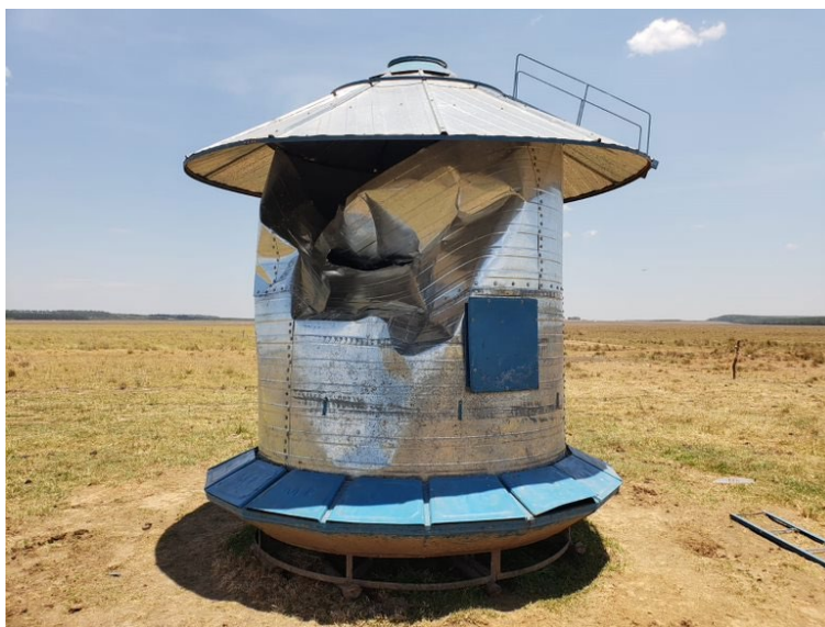
Figura 4. Otros daños del LV-WZE. Fuente: investigación JST
