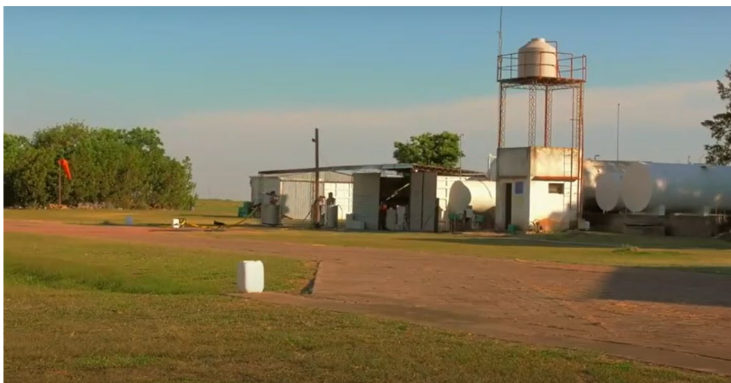
Figura 8. Depósitos de combustible. Fuente: investigación JST
