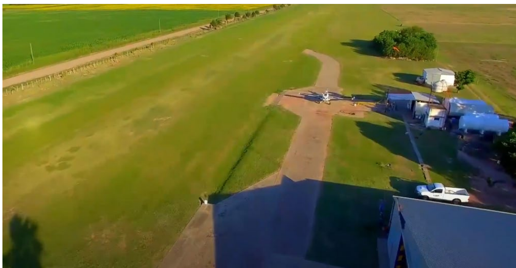
Figura 9. Vista superior depósitos de combustible. Fuente: investigación JST
