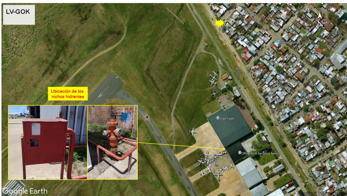
Figura 33. Ubicación de los nichos hidrantes utilizados. Fuente: investigación JST
