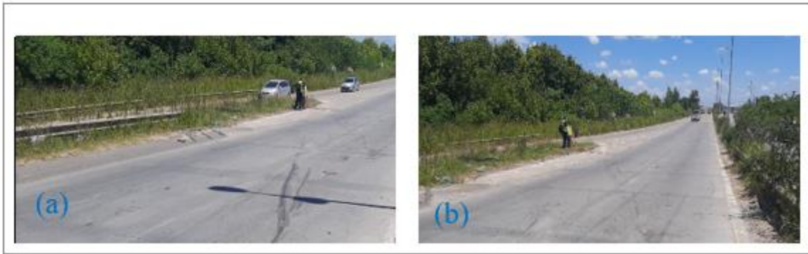
Figura 56. Imágenes representativas de la calzada descendente con sentido hacia Campana; (a) imagen de la calzada y banquina externa donde se observan alertadores tipo rodilladas de asfalto; (b) imagen de calzada y banquetas con pasto crecido e invasiones de material vegetal en las banquetas. Fuente: JST, 2021
