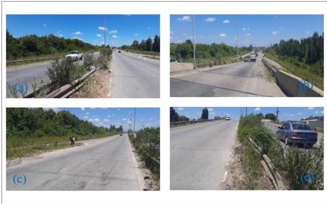
Figura 59. Imágenes representativas de los elementos de la infraestructura vial: (a) imagen de mediana entre ambas calzadas, con barreras semirrígidas, postes de iluminación y pasto crecido; (b) imagen de los dos tipos de barreras en la mediana y laterales de la vía (rígida y semirrígida); (c) imagen de material vegetal crecido (pasto) que tapa la visibilidad de las barreras de contención; (d) imagen de la barrera pandeada por el golpe de la cisterna. Fuente: JST, 2021
