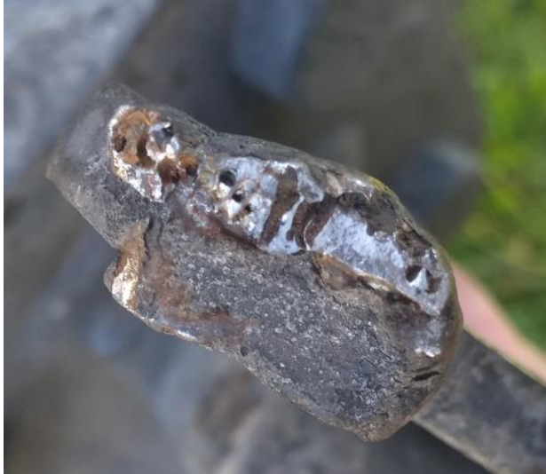
Figura 36. Cara de fractura de la soldadura. Fuente: JST, 2021
