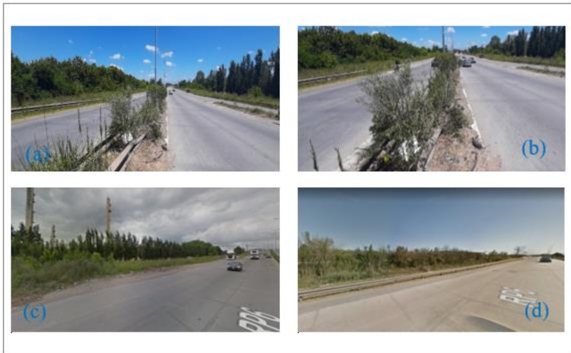
Figura 58. Imágenes representativas de los costados de las calzadas: (a) imagen de toda la zona de camino donde ocurrió el suceso que incluye los costados de calzadas; (b) imagen de la mediana costado interno de las calzadas. (c) imagen de costado de calzada descendente se observa banquina de material vegetal y talud. (d) imagen de costado de calzada ascendente se observa la barrera de contención metálica y el talud hacia el curso de agua. Fuente: JST,2021.
