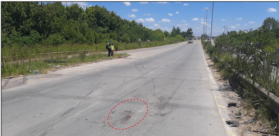
Figura 24. Fotografía de conjunto de efracciones en la calzada generadas por ambos vehículos en la colisión. Fuente: JST, 2021
