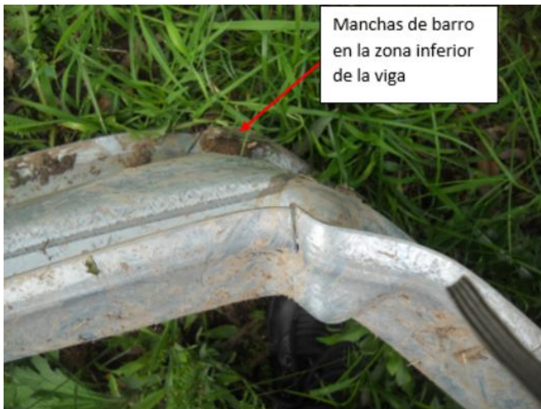
Figura 14. Zona del pliegue de la barrera. Fuente: JST, 2021.
