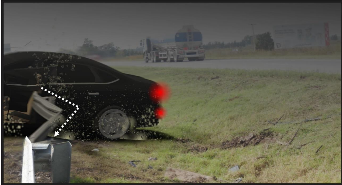
Figura 25. Deformación de la barrera de contención. Fuente: JST, 2022.
