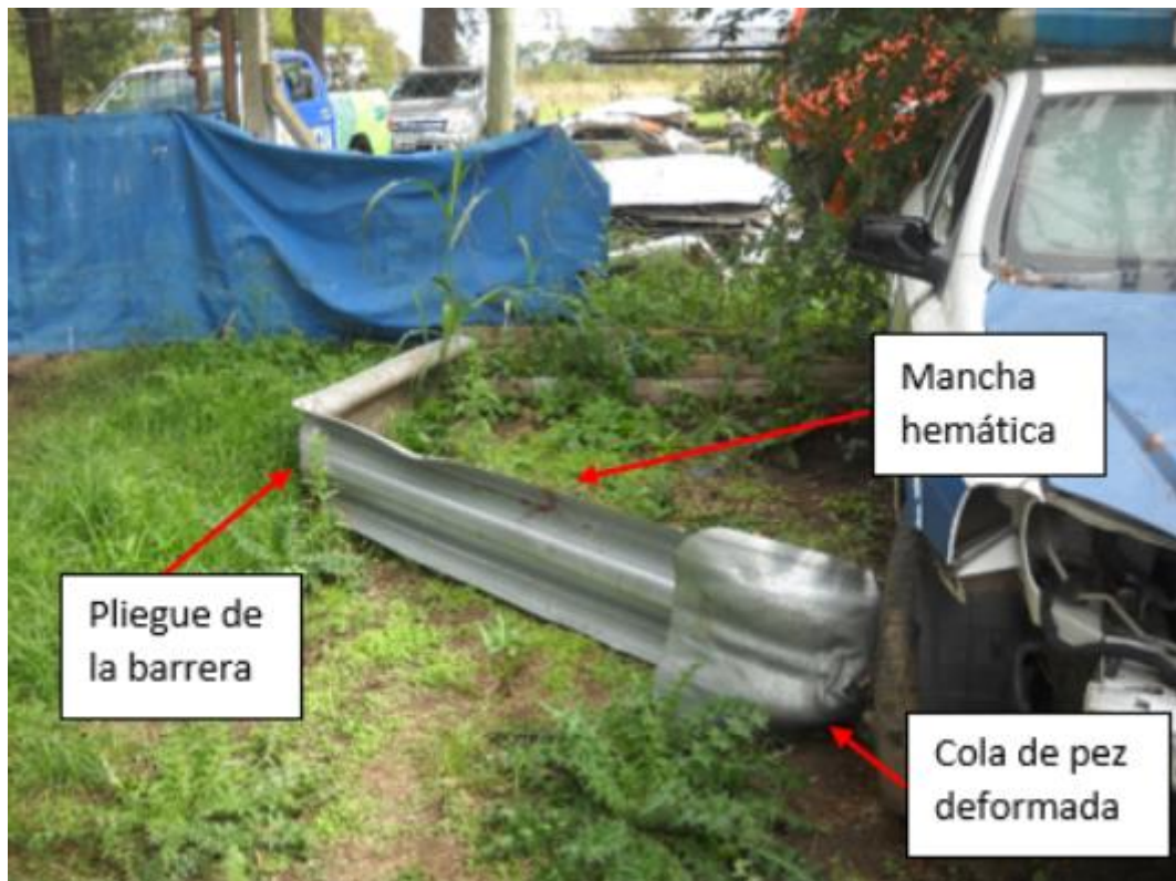
Figura 12. Tramo de la barrera desprendido. Fuente: JST, 2021.
