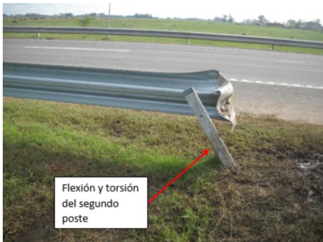
Figura 15. Deformación del tercer poste. Fuente: JST, 2021.
