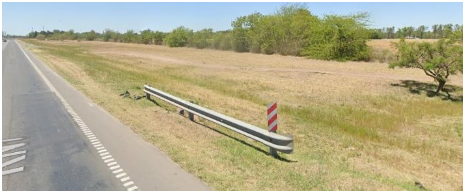
Figura 9. Barrera de contención lateral con terminal de cola de pez
