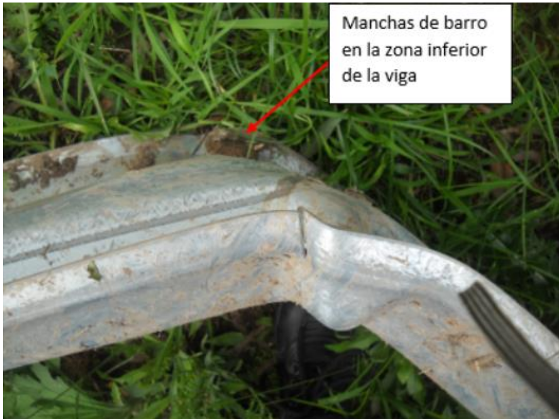
Figura 15. Zona del pliegue de la barrera. Fuente: JST, 2021
