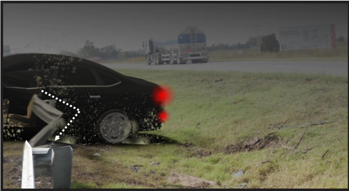
Figura 26. Deformación de la barrera de contención. Fuente: JST, 2022.
