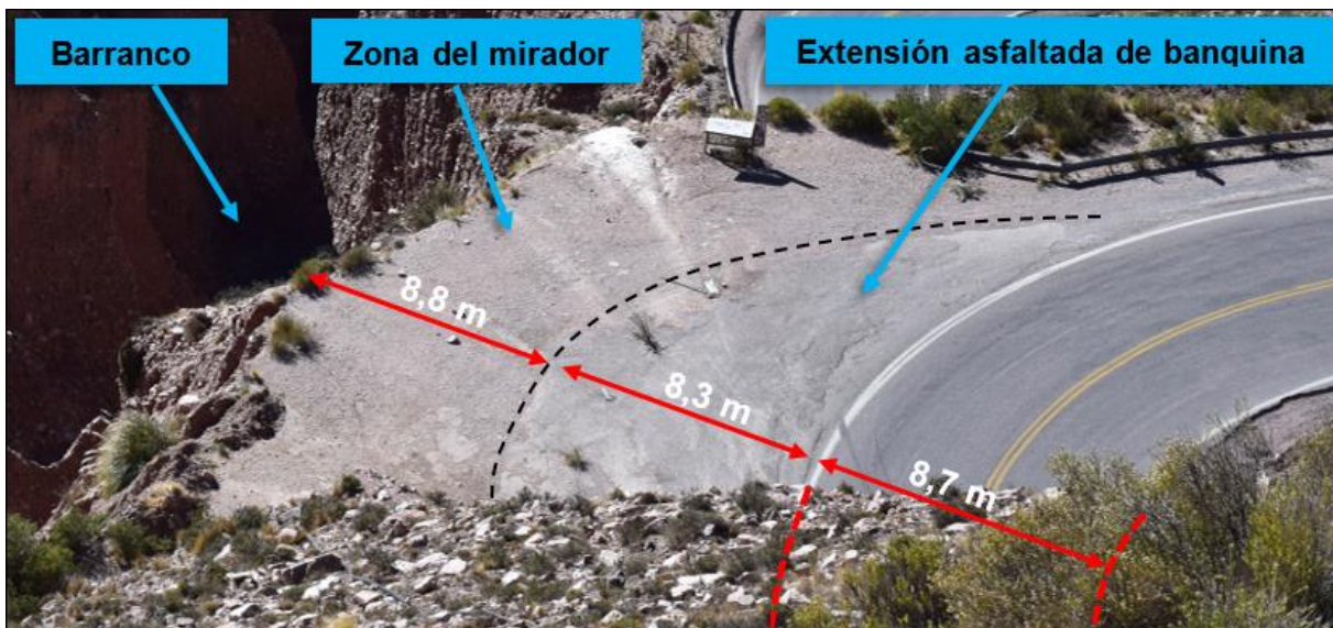
Figura 10. Dimensiones de banquina asfaltada y zona de mirador en la curva del despiste
