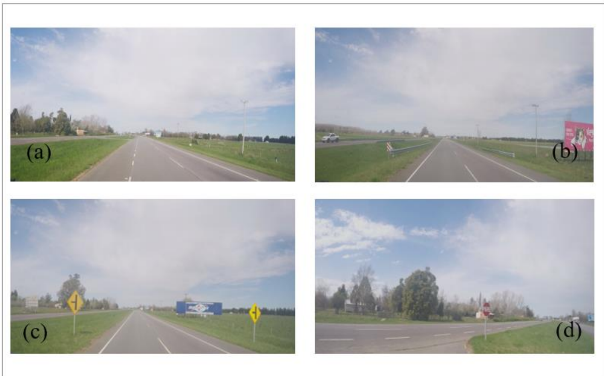
Figura 29. Señalización calzada ascendente
