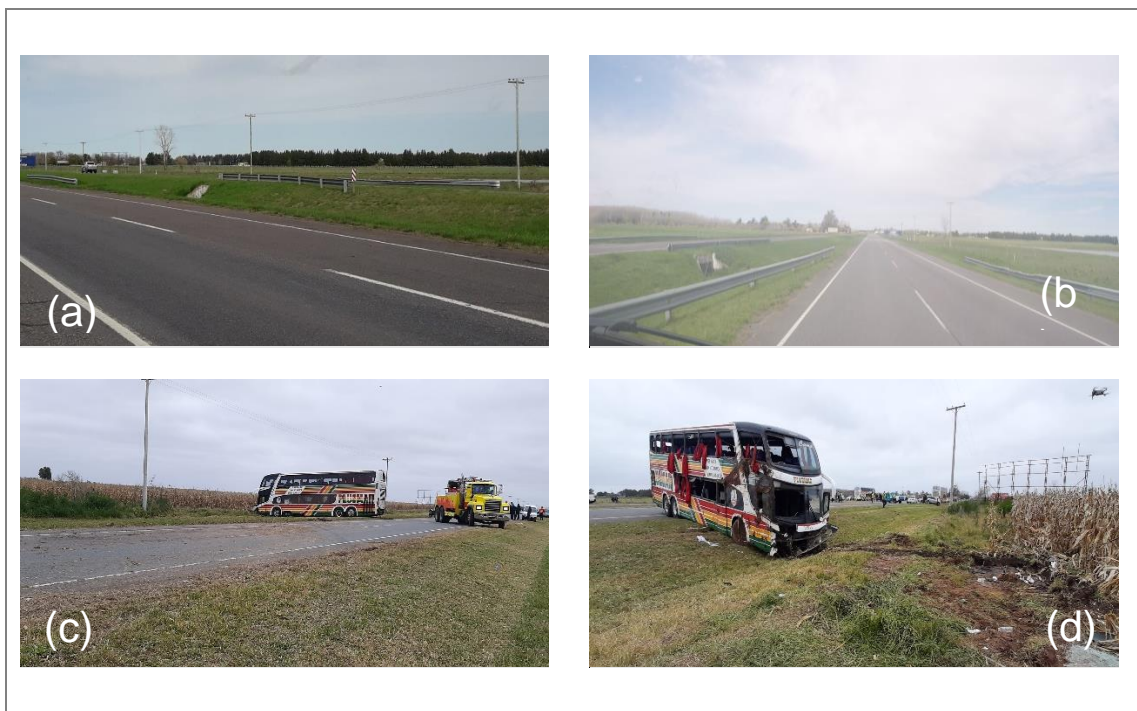
Figura 33. Objetos rígidos al costado de la calzada
