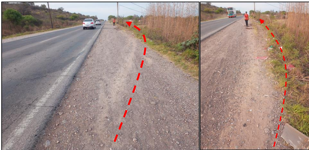
Figura 11. Huellas de derrape demarcadas sobre la banquina este y zona de préstamo contigua por las ruedas del Vehículo 1. Fuente: JST.
