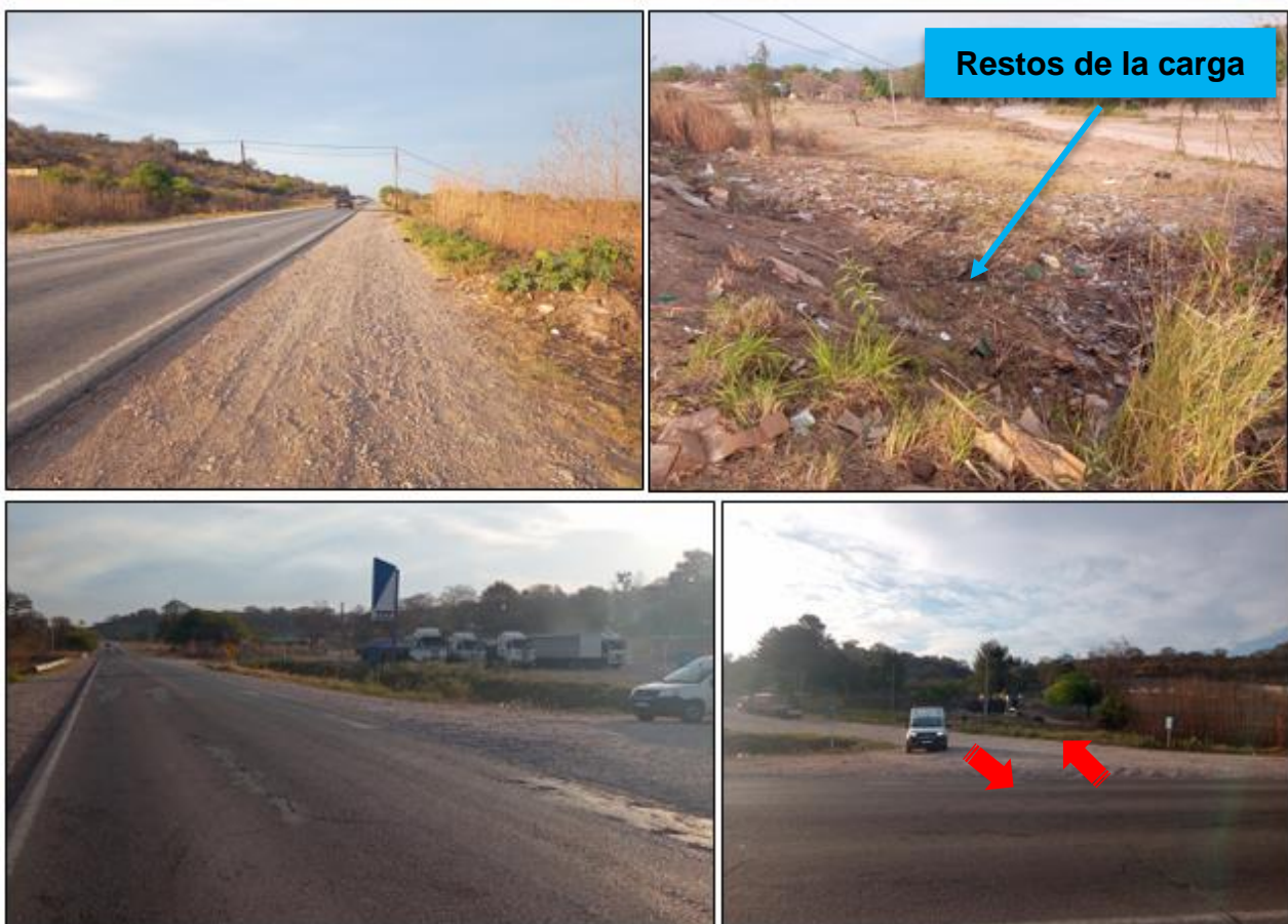
Figura 6. Arriba: Fotografías del costado este de la calzada (banquina y talud), donde se produjo el despiste y vuelco del Vehículo 1. Abajo: fotografías de la estación de servicio YPF hacia el costado oeste de la ruta y sus ingresos/egresos. Fuente: JST, 2021.
