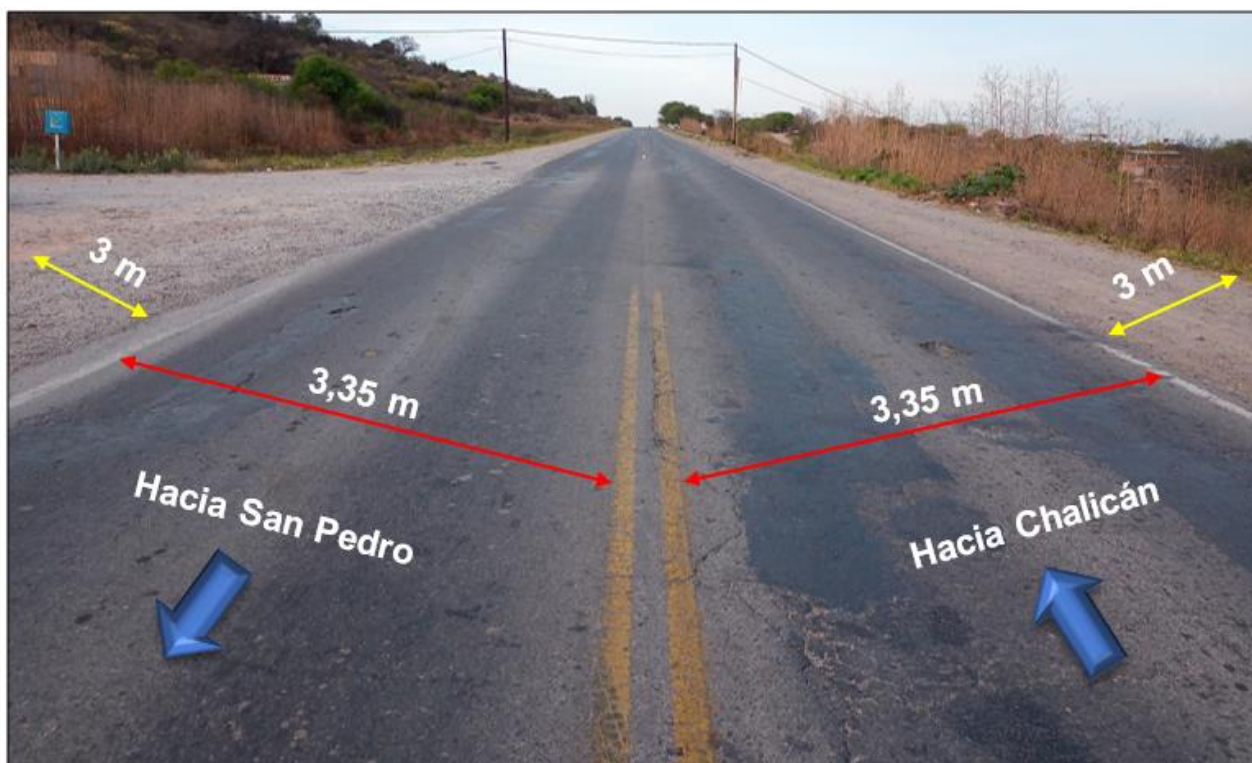
Figura 4. Fotografía con vista sur-norte donde se indican las dimensiones de calzada y banquina del sector de la ruta donde ocurrió el suceso. Fuente: JST, 2021.
