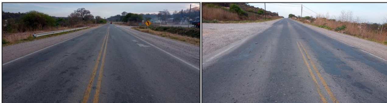
Figura 7. a) y b). Fotografías en ambos sentidos de la vía donde se visualiza la doble línea amarilla y las líneas blancas de borde de calzada.
