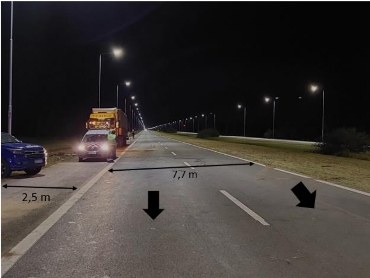
Figura 5. Fotografía posaccidente donde se puede observar el buen estado de la calzada y sus medidas correspondientes. Fuente: JST
