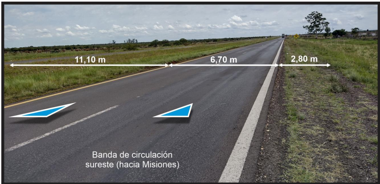
Figura 3. Captura de la vía con vista hacia el cardinal noreste, en la cual se puede apreciar la banda de circulación sureste por la que se desplazaban previamente los vehículos protagonistas del suceso, las condiciones de la calzada y la señalización horizontal demarcada sobre ellas. Fuente: JST.
