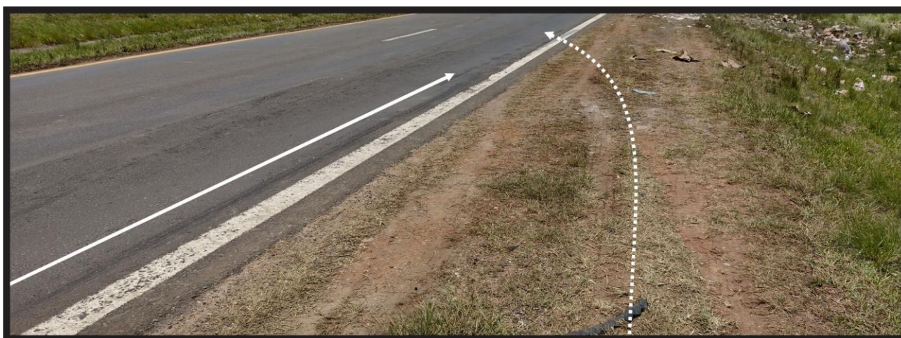
Figura 17. Marca de neumático sobre la banquina y proyectada hacia la calzada, señalada con línea punteada. Sobre el carril derecho, impronta de neumático que se proyecta hacia la banquina, indicada con línea punteada. Ambas huellas son identificadas como H. Fuente: JST, 2021.
