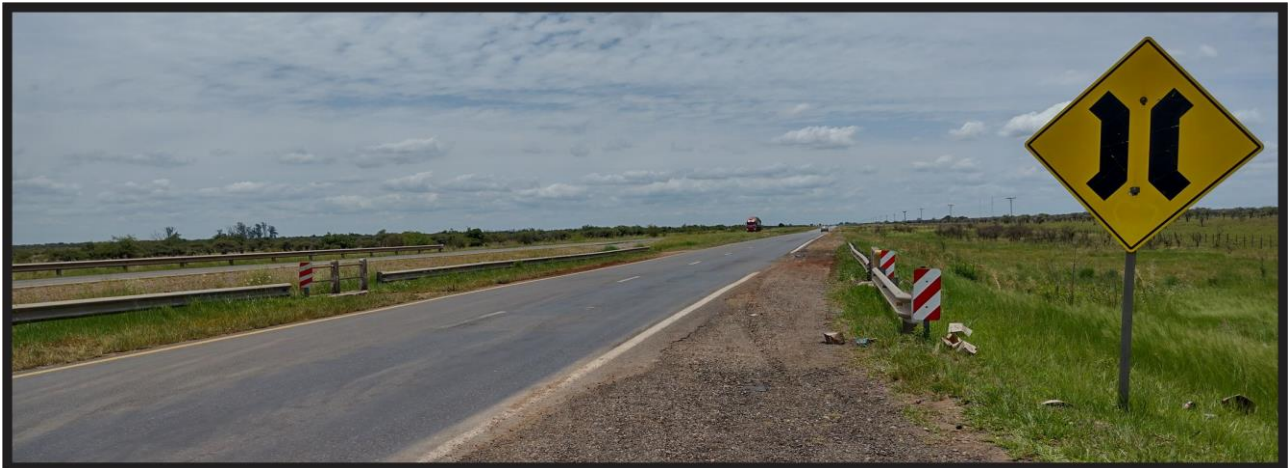
Figura 7. Señal vertical preventiva de puente ubicada previo al lugar del suceso. Fuente: JST, 2021.
