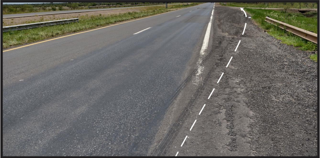
Figura 12. Fotografía que muestra la continuidad de la marca de neumático identificada como B sobre la banquina de ripio de la ruta, la cual fue indicada mediante línea discontinua. Fuente: JST, 2021.
