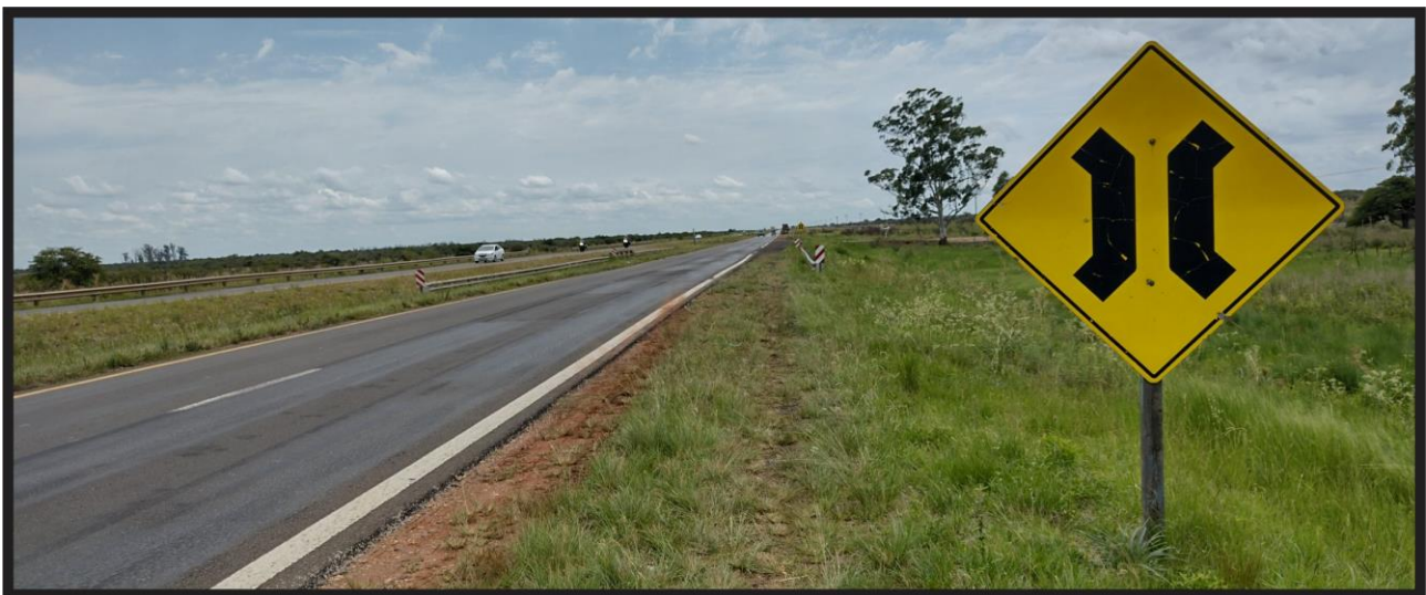
Figura 6. Señal vertical preventiva de puente ubicada previo al lugar del suceso. Fuente: JST, 2021.
