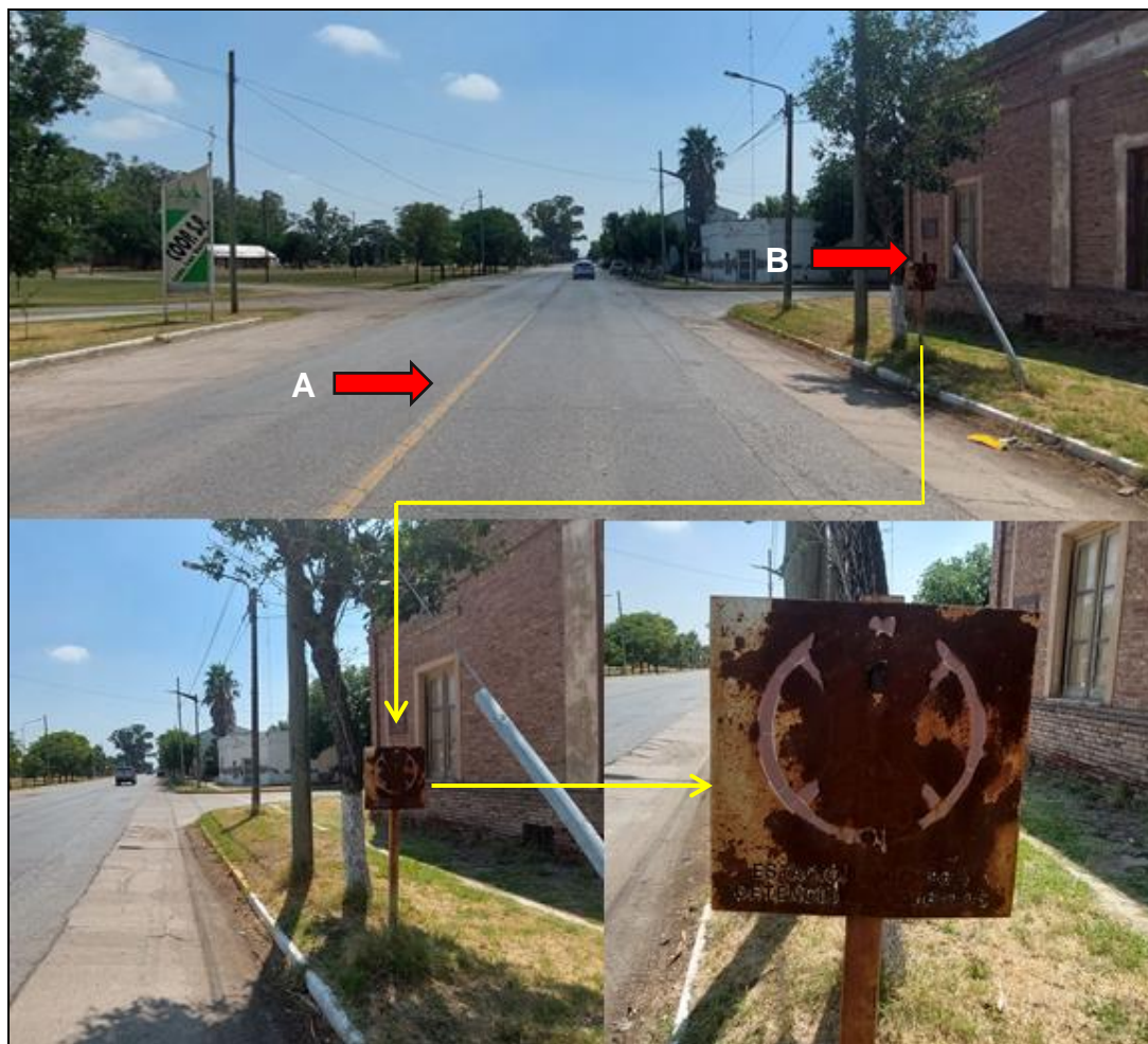
Figura 4. Señalización vial documentada en sentido suroeste a noreste. A) Señalamiento horizontal y longitudinal de separación de sentidos de circulación y prohibición de sobrepaso. B) Señalización vertical en mal estado del tipo prescriptiva que prohíbe estacionamiento y detención en la zona de impacto. Fuente: JST, 2022.
