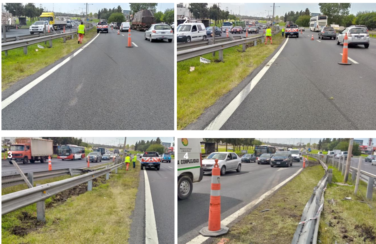
Figura 12. Huellas de frenado y daños a las barreras de contención del tipo flex beam generadas por Vehículo 1. Fuente: JST, 2022
