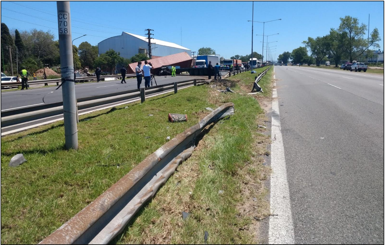
Figura 5. Zona de despiste y huellas que atraviesan el cantero central, desde la mano de circulación hacia Rosario, hacia el sentido de circulación opuesto, donde ocurrió la colisión. Fuente: JST, 2022.
