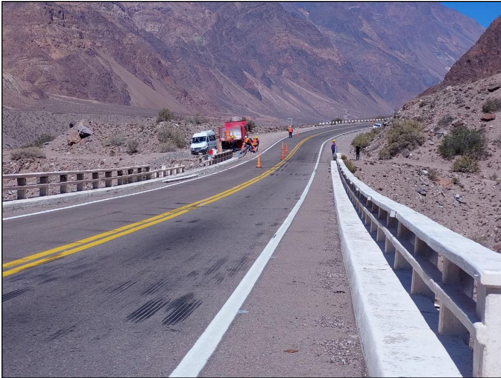
Figura 12. Lugar del suceso. Panorámica del puente en el sentido opuesto al de circulación del vehículo accidentado. Se puede observar la curva y pendiente de la vía, próxima al puente. También se observan huellas de frenados intermitentes en otros sectores de la vía. Fuente: JST, 2022
