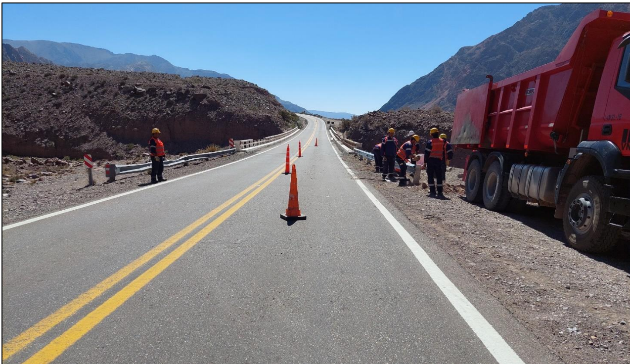
Figura 6. Lugar del suceso al momento del arribo. Personal de Vialidad Nacional reacondicionando la infraestructura vial dañada. Se sustituyeron 20 m de flex beam ubicada sobre el sector sudeste. Fuente: JST, 2022
