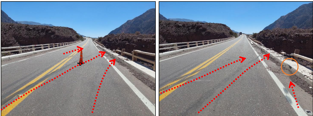
Figura 9. Puente. Sector inmediato al despeñamiento del vehículo accidentado. Se pueden observar improntas neumáticas sobre la calzada. Dentro del círculo (a la derecha de la imagen), marca del impacto de un neumático, luego la rotura del parapeto este. Fuente: JST, 2022
