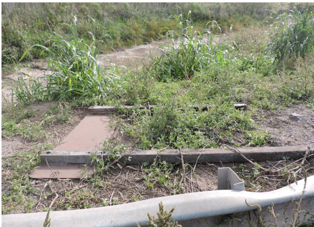
Figura 5. Cartelería caída en terreno lindante norte. Fuente: JST, 2022
