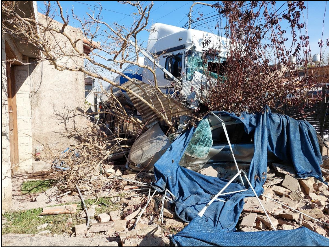
Figura 12. Vista general desde el interior de la vivienda 1747 hacia el sur. Posición final del Vehículo 1 y del Vehículo 5. Fuente: JST, 2022
