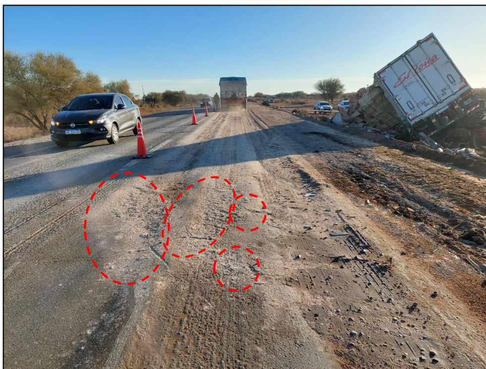
Figura 5. Carril cardinal este (mano hacia San Juan). Se observan múltiples efracciones (hendiduras) sobre la calzada. Fuente: JST, 2022
