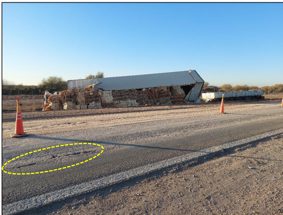
Figura 9. Vista panorámica desde la banquina oeste (mano hacia Mendoza). Se observan fisuras longitudinales sobre el pavimento y el semirremolque del Vehículo 2 con carga dispersa sobre el talud y zona de préstamo del cardinal este. A la derecha, el semirremolque del Vehículo 1 en la misma zona. Fuente: JST, 2022
