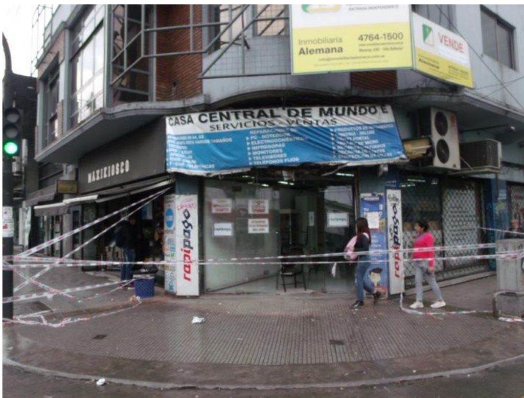
Figura 9. Daños en el local comercial luego del impacto. Fuente JST, 2022
