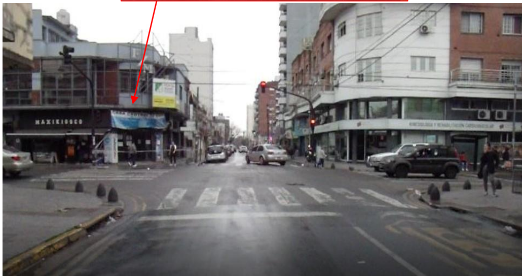
Figura 4. Vista de calle Moreno, previo a intersección con calle Campos. Arriba, detalle de la esquina norte. Fuente JST, 2022.
