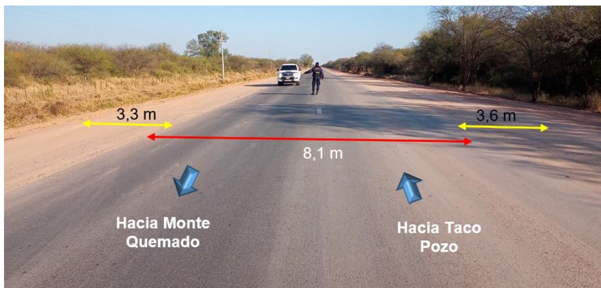
Figura 3. Dimensiones y estado de la vía en proximidades a la zona de impacto. Fuente: JST, 2022
