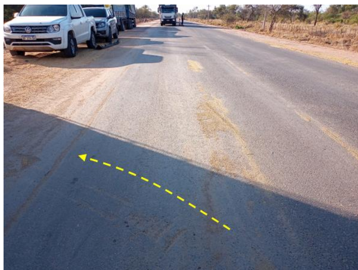
Figura 28. Huella de efracción dejada por uno o ambos rodados en la zona de colisión. Fuente: JST, 2022
