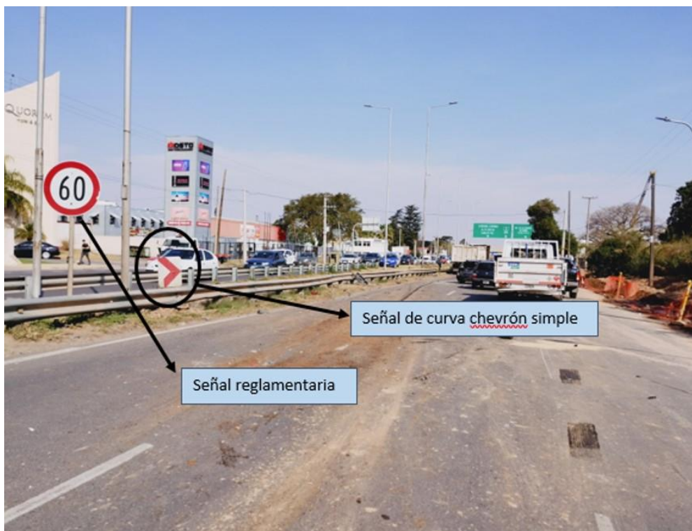
Figura 4. Señalización vertical del lugar del suceso. Fuente: JST, 2022
