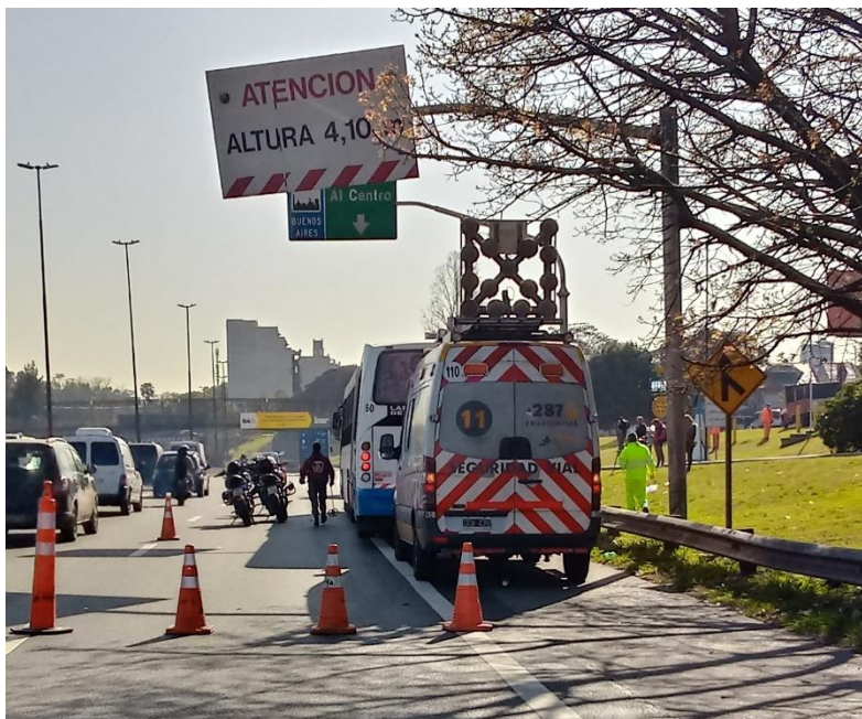
Figura 5. Señalización vertical de altura máxima e incorporación de tránsito lateral. Fuente JST, 2022
