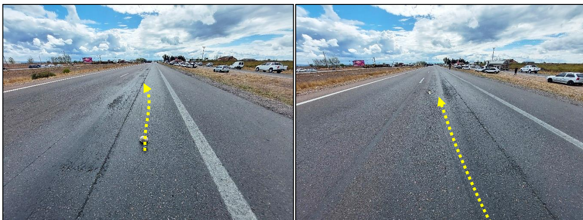
Figura 7. Huella de derrape situada sobre el carril norte (derecho de la imagen), con dirección hacia el suroeste. Fuente: JST, 2022
