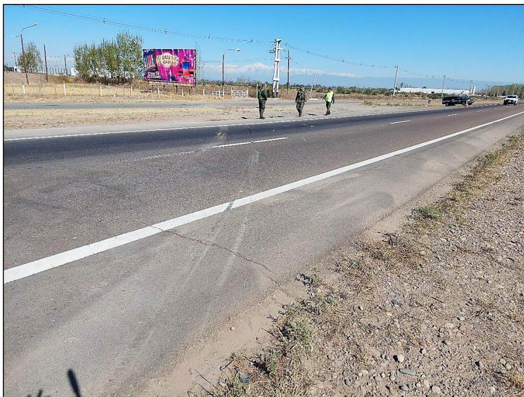
Figura 15. Fotografía tomada dos días después del suceso. Se aprecian huellas de derrape de 17 metros de longitud, con dirección hacia el suroeste. Sobre el carril y banquina sur (izquierda de la imagen) se observan marcas de efracción y hendiduras. Fuente: JST, 2022
