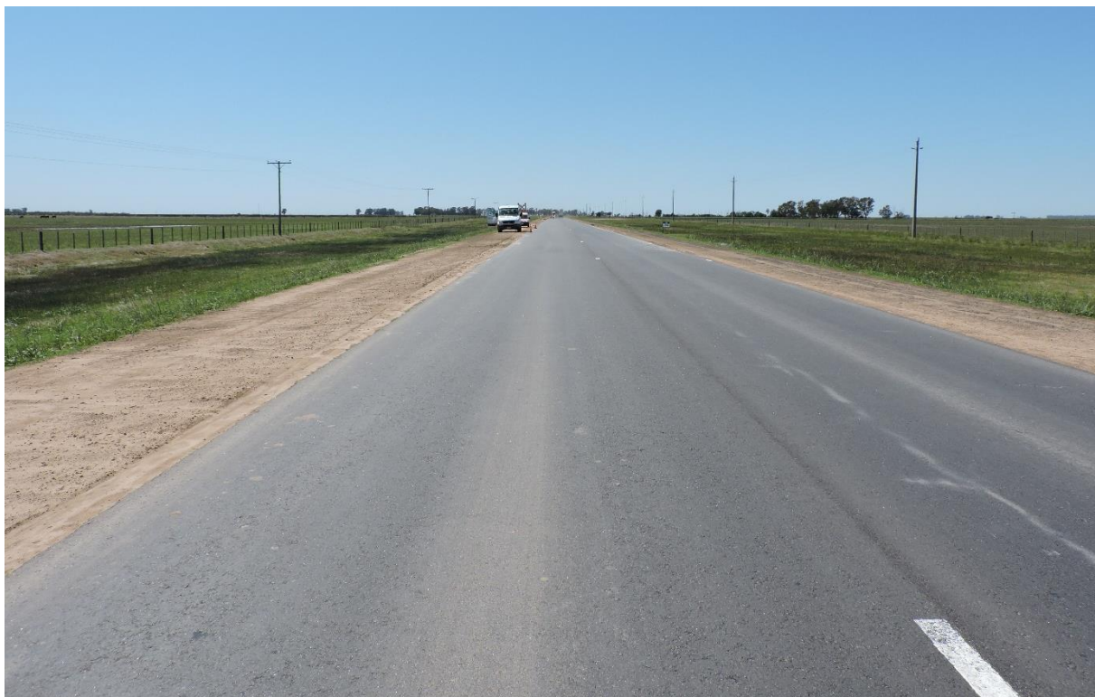
Figura 3. Vista de la zona previa al accidente con sentido hacia la provincia de Buenos Aires. Fuente: JST, 2022
