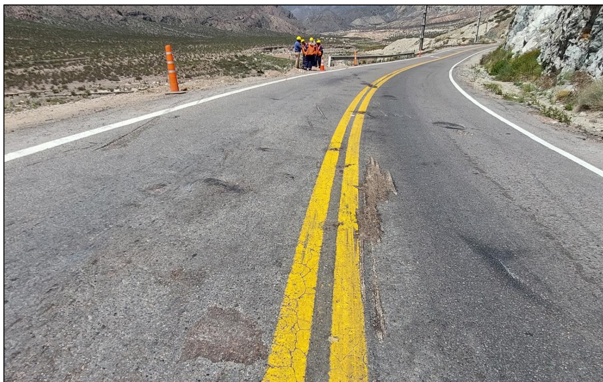
Figura 18. Zona de impacto entre el Vehículo 1 y Vehículo 3. Sobre el carril externo de la curva, se observan manchas de fluidos mecánicos estáticos recientes que demuestran la posición final del Vehículo 3. Fuente: JST, 2023
