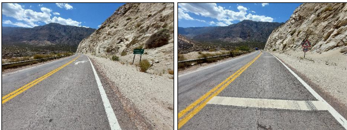
Figura 8. Ruta Nacional 7, mano hacia Mendoza. Se observan fallas sobre la calzada con bandas auxiliares de reducción de velocidad y flecha curva demarcada. Sobre el margen derecho: cartel informativo (curva de Guido) y cartel preventivo compuesto de: curva inclinada y velocidad máxima 60 km/h. Fuente: JST, 2023
