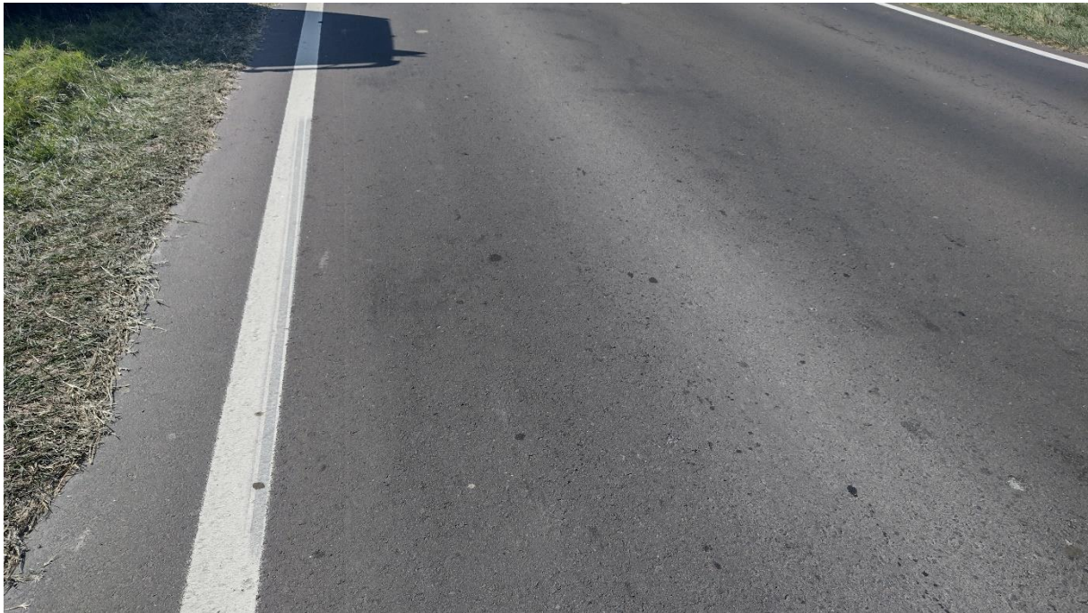
Figura 33. Marca de frenada hallada en el margen de la calzada. Fuente: JST, 2023
