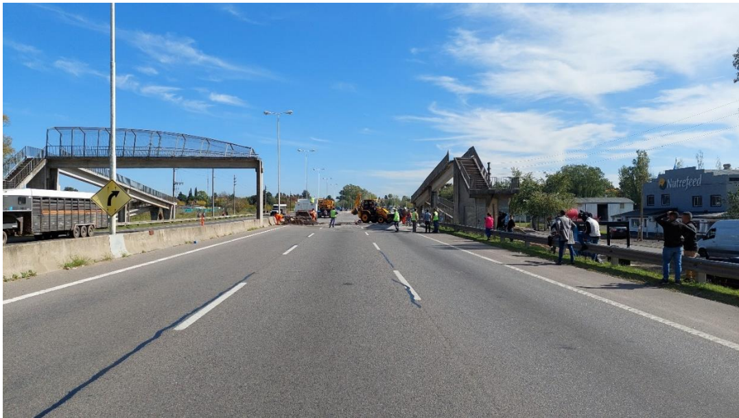
Figura 19. Vista por donde circulaban ambos vehículos en su dirección de marcha, hacia el puente peatonal. Fuente: JST, 2023
