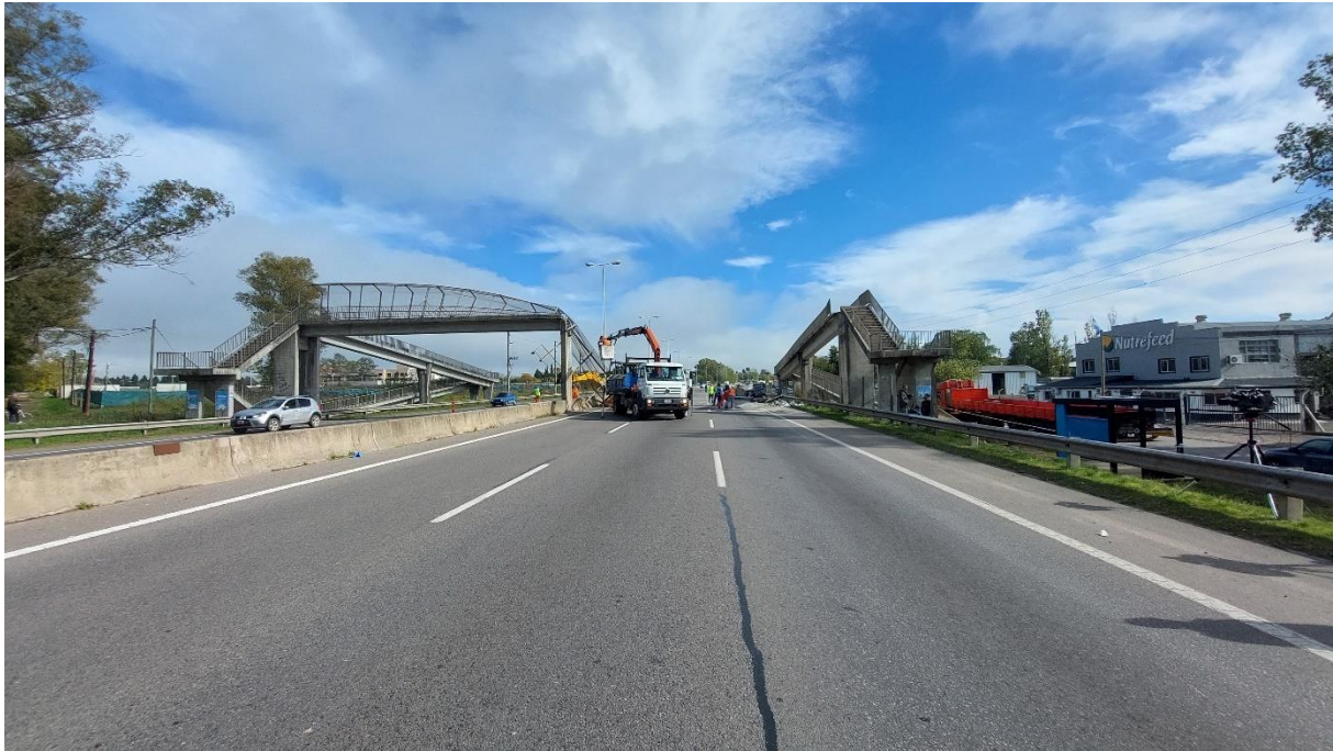
Figura 3. Líneas demarcadoras de calzada y líneas blancas discontinuas de separación de carriles, con vista hacia RP 6. Fuente JST, 2023
