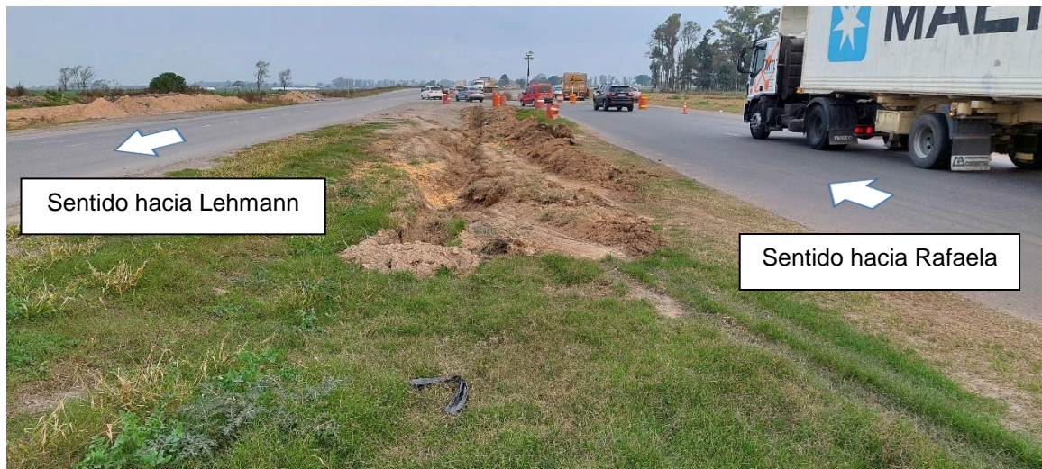
Figura 3. Calzada dividida tomada desde la posición final del Vehículo 1. Fuente: JST, 2023
