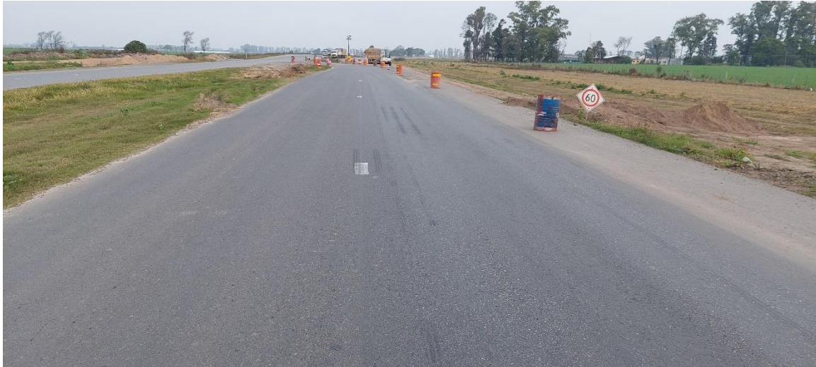
Figura 4. Ingreso a la zona de transición, sobre la calzada oeste, en sentido a Rafaela. Fuente: JST, 2023
