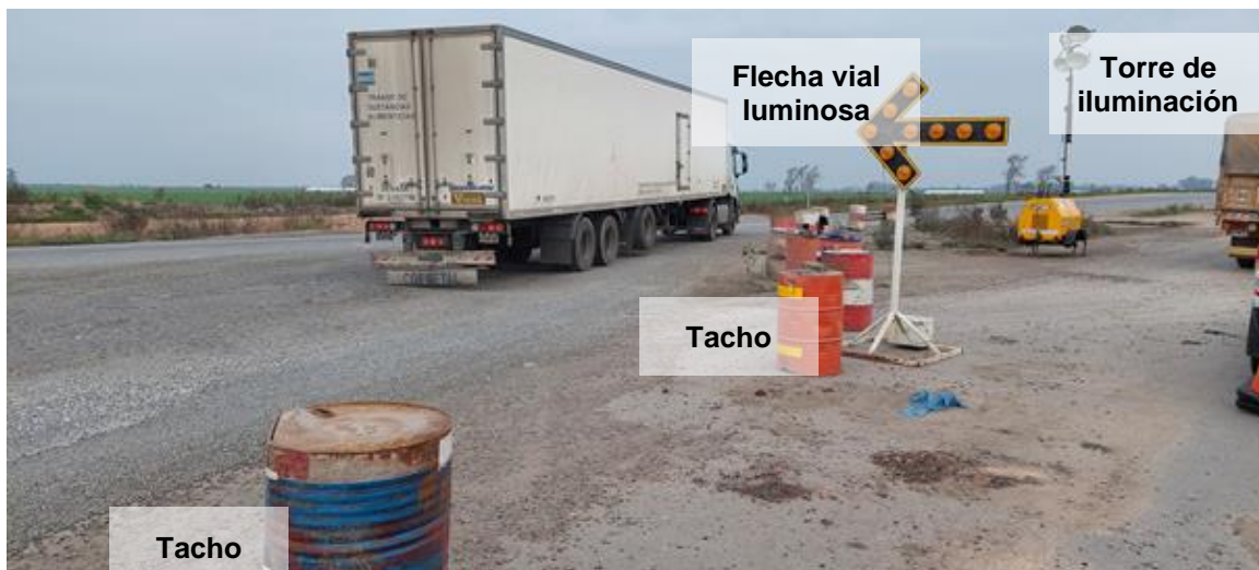
Figura 5. Señalización transitoria de la reducción de calzada. Fuente: JST, 2023
