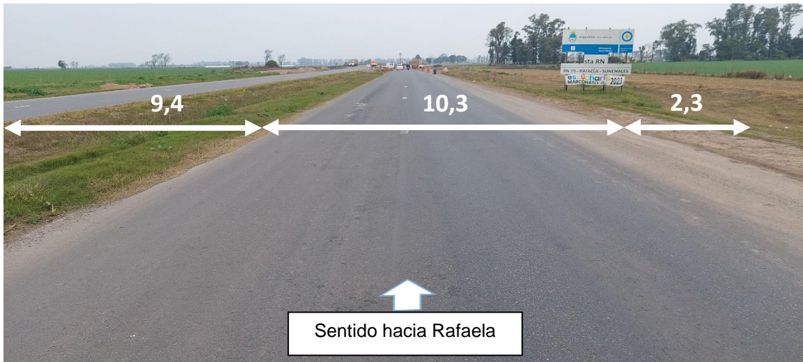
Figura 6. Dimensiones de la calzada oeste. Fuente: JST, 2023
