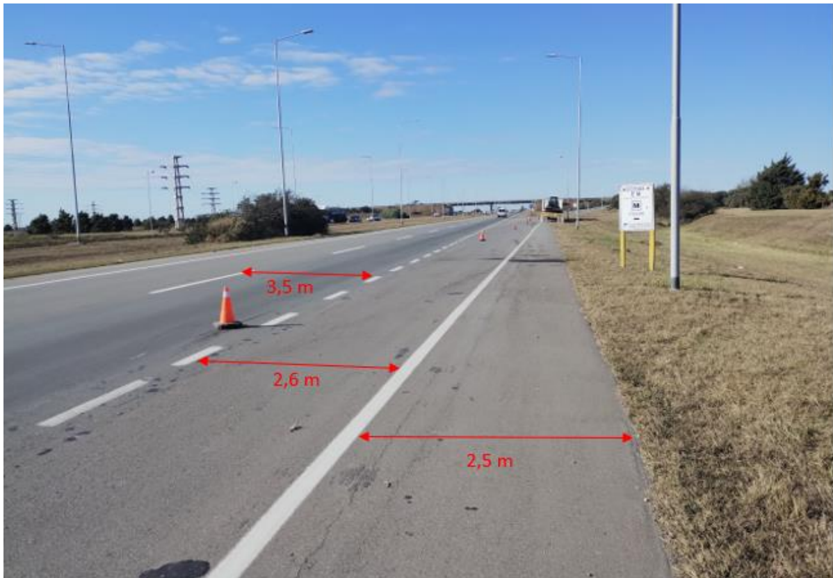
Figura 3. Características y medidas de la vía donde ocurrió el suceso. Fuente: JST, 2023
