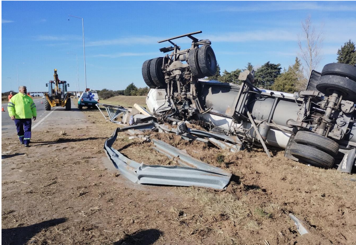
Figura 12. Daños sobre la barrera semirrígida de contención post impacto. Fuente: JST, 2023
