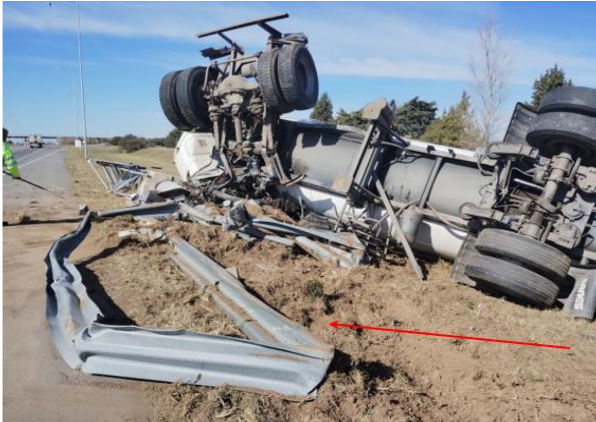
Figura 5. Se observa la barrera de contención con deformaciones producto del choque y desprendida de sus puntos de anclaje. Fuente: JST, 2023
