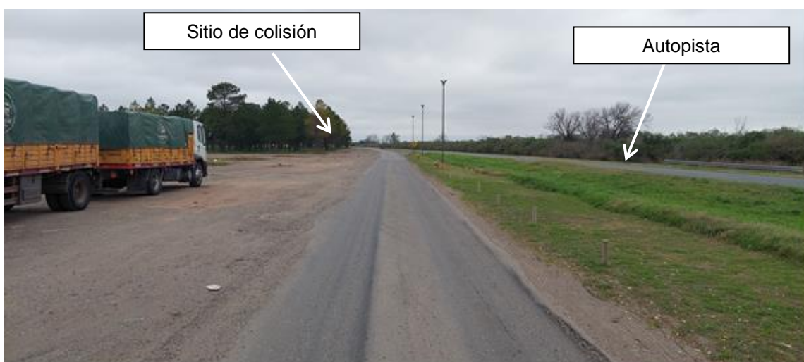
Figura 5. Infraestructura del camino de incorporación a la autopista. Fuente: JST, 2023
